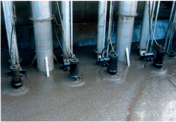
Durch die Verwendung von Spezialbeschichtungen wie der hochwertigen Zwei-Komponenten-Beschichtung „Wilo Ceram“ können Rührwerke, Pumpen- und Anlagenteile wirkungsvoll vor Korrosion und Abrasion geschützt werden. © WILO SE
