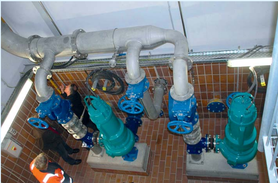
TROCKENAUFSTELLUNG: Die hygienischere Variante
