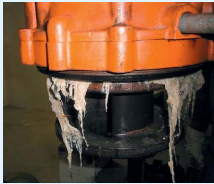
TYPISCHE SCHADENSBIlder: Verzopfungen im Laufrad (links) und im Radseitenraum
