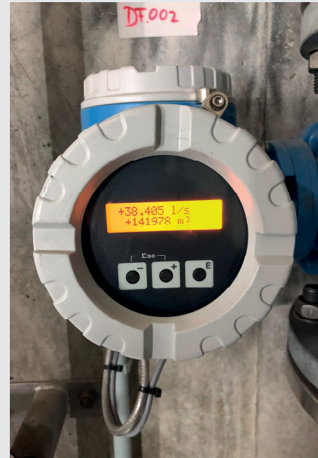
Bild 5 Die gewünschte Durchflussmenge wurde am Durchflussmesser auf den Sollwert eingestellt. Quelle: Wilo
