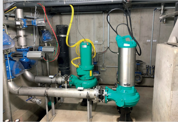
Bild 2 Pumpe vom Typ Wilo-Rexa SOLID-Q mit Nexos-Intelligenz im Pumpwerk Quelle: Wilo
