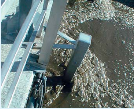
Rückströmung durch Belüfterwalze
