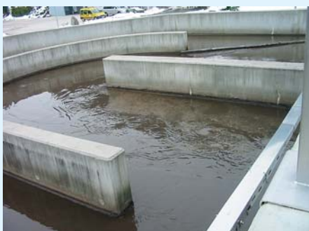
Ablösewirbel durch Umlenkung
