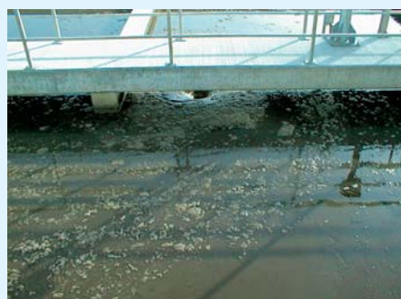
Rückströmung an Trennwand
