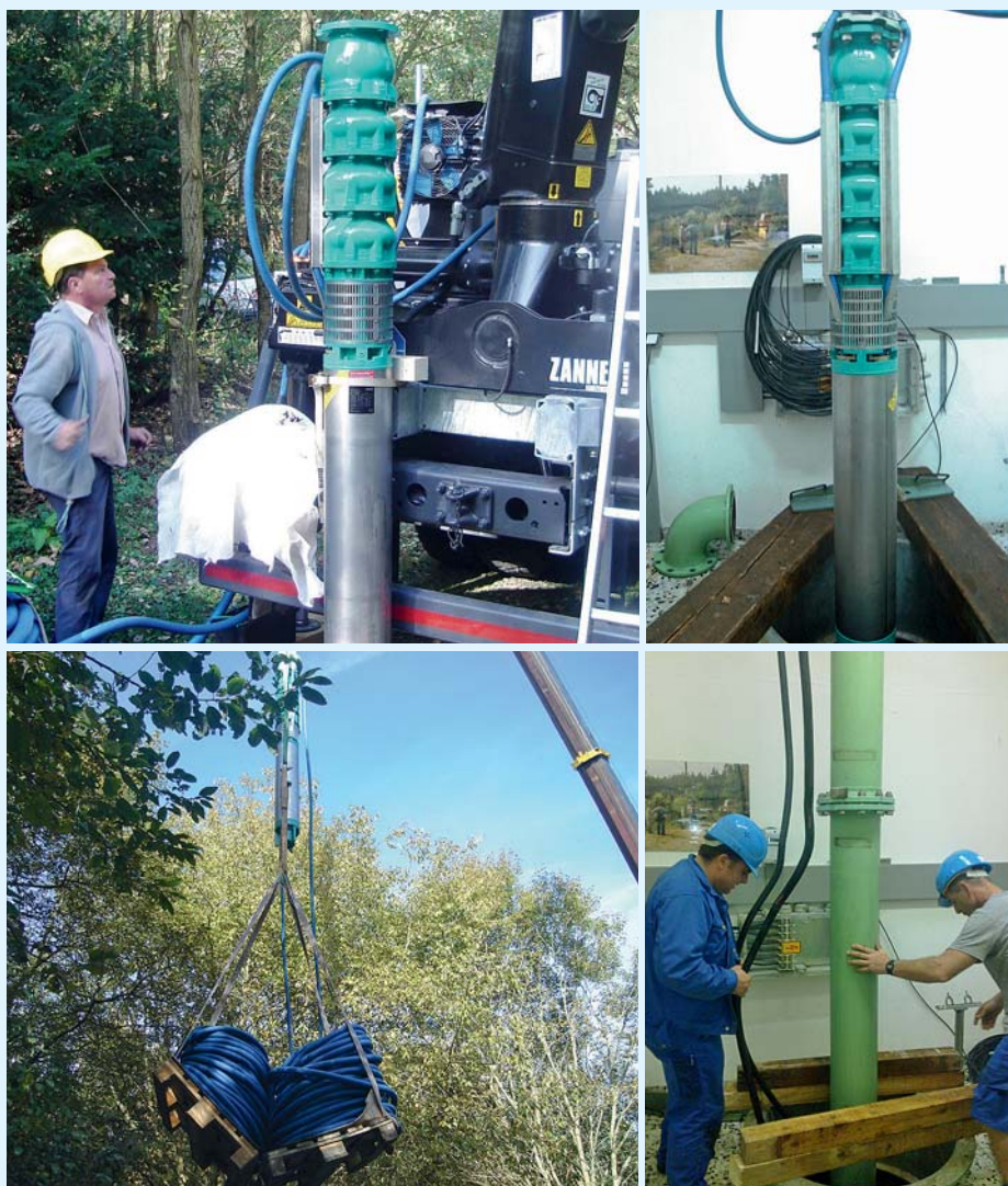
Bild 11 bis 14 Einbau der Pumpen in Brunnen VI
