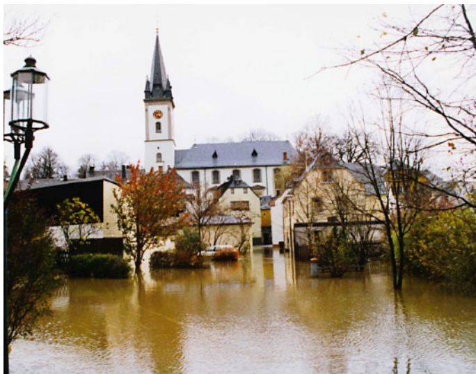
Hochwässer richteten in Schwarzenbach an der Saale wiederholt grosse Schäden an Gebäude und Infrastruktur an.
