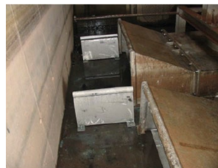
Zulaufkammern für Axialmaschinen.
