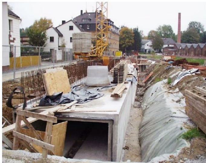
Aus Platzgründen wurden in Schwarzenbach die neuen Stahlbetonmauern teilweise auf einem Stauraumkanal errichtet.
