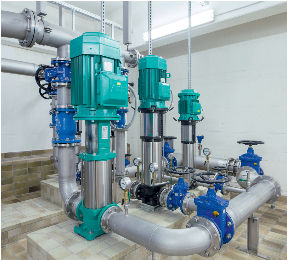
Bild 6 Aufstellung der vertikalen Kreispumpen
